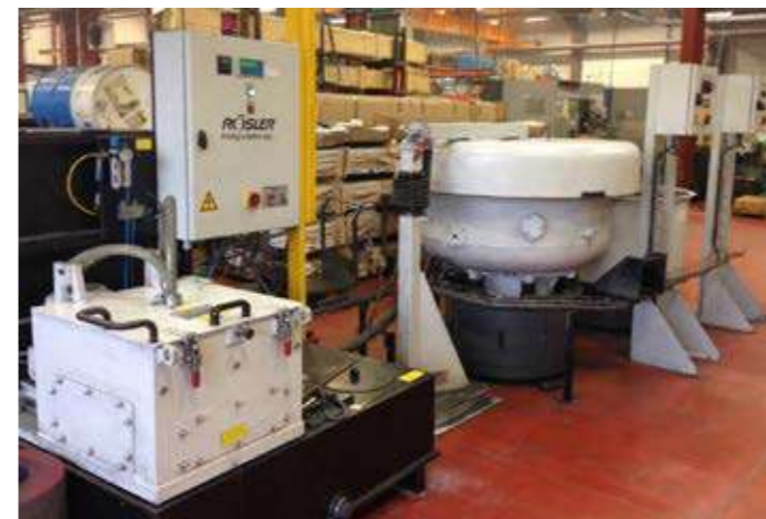
> Traitement des effluents de tribofinition dans une entreprise de décolletage à Vougy. Budget 22 000€ – Aide financière de 60%.
