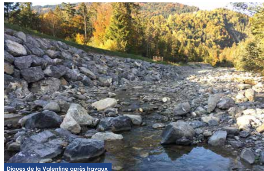
Digues de la Valentine après travaux
