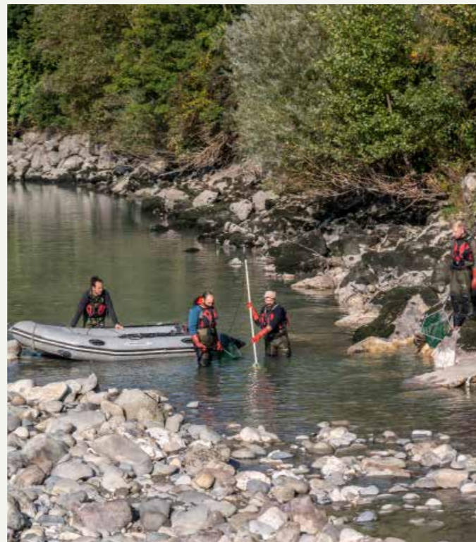
Pêche de sauvetage réalisée avant les travaux
