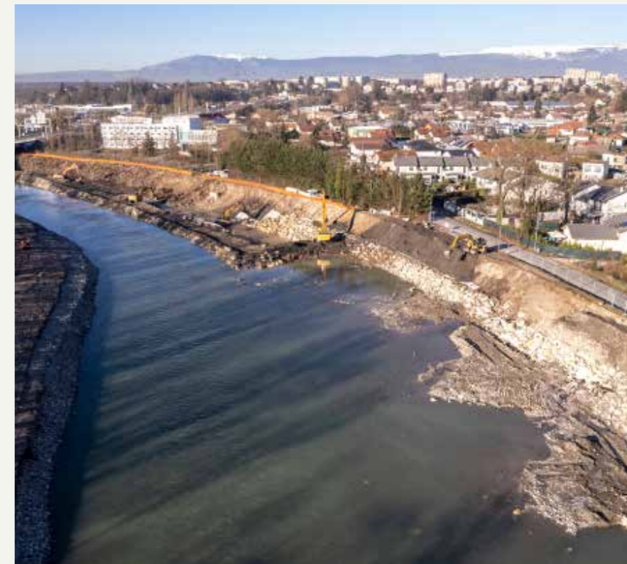
La digue de la Châtelaine protège 102 logements et 21 entreprises
