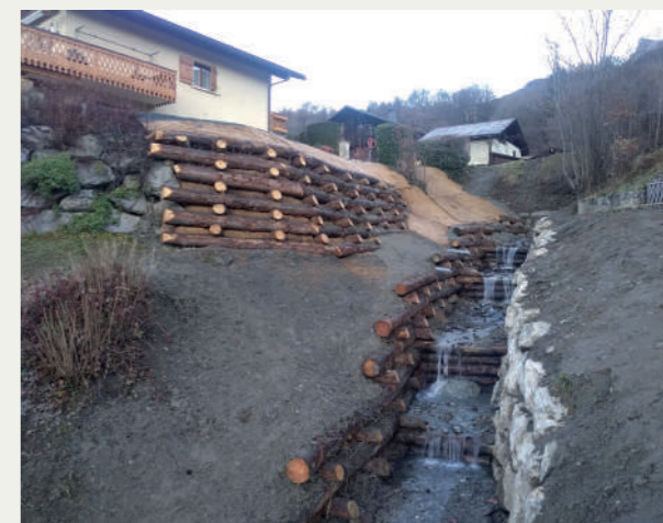
Aménagement réalisé par le SM3A (rive droite et seuils brise charge)
