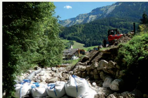
Batardeau sur le Foron du Reposoir
