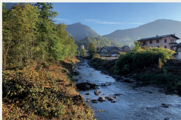
Le Foron de Taninges avant intervention
