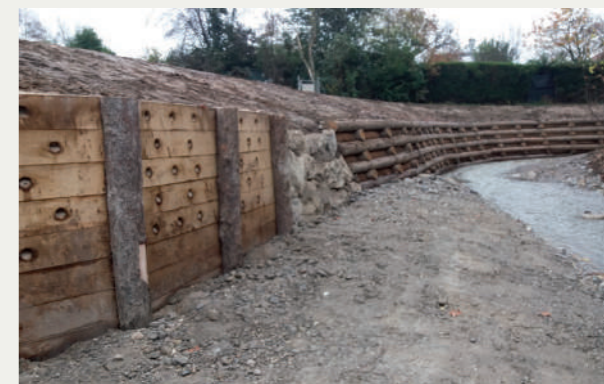
Falaise à Martin Pêcheur et caissons végétalisés
