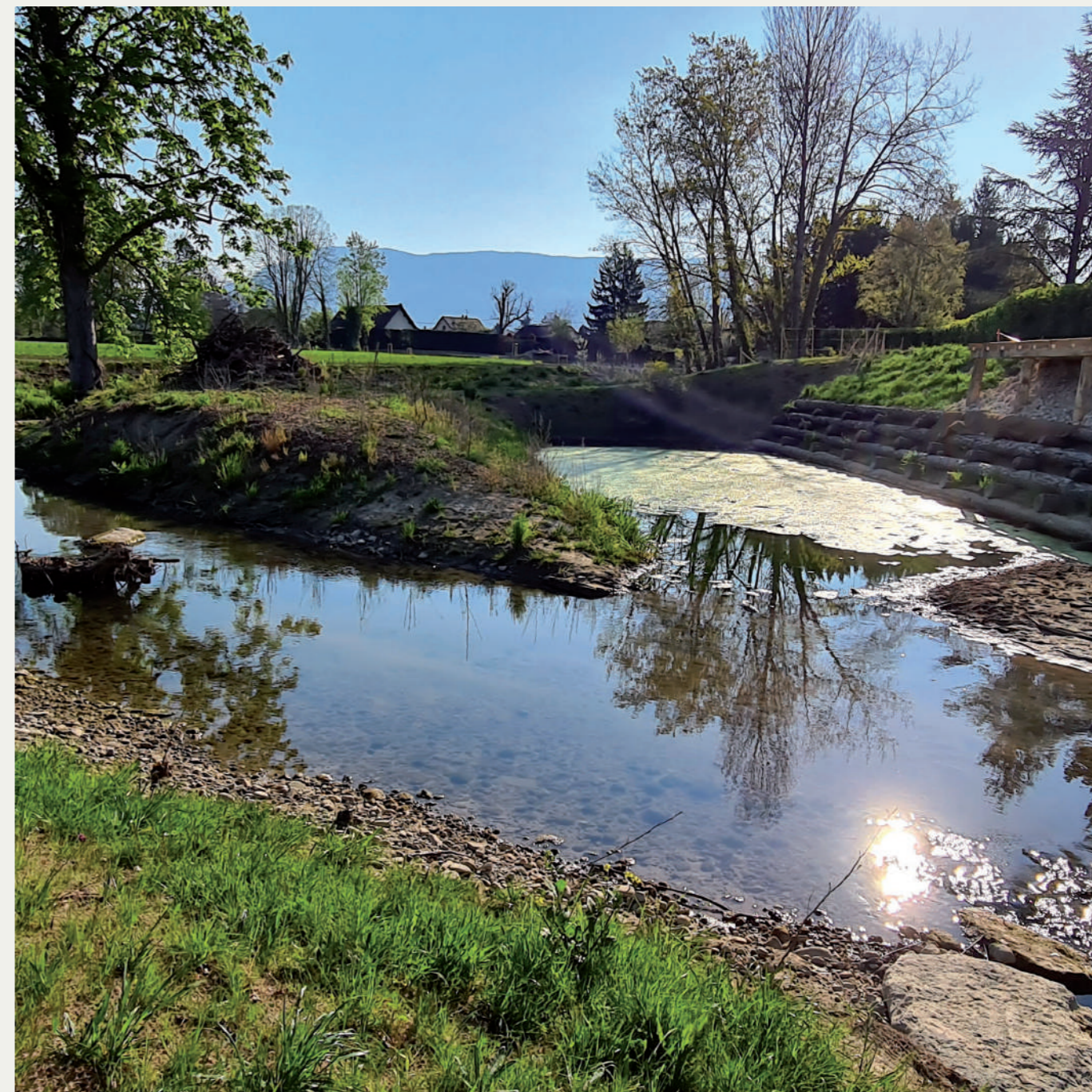
Le Foron du Chablais Genevois à Ambilly après reméandrage du lit et des annexes hydrauliques
