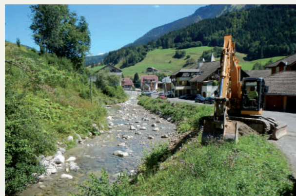
Le Foron du Reposoir après intervention
