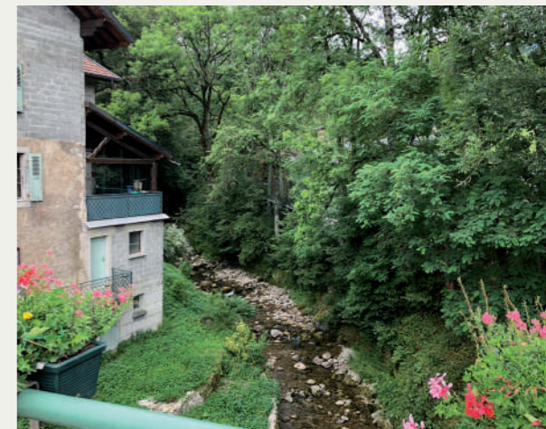
Le Foron de Mieussy avant intervention
