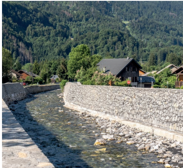
Digue du Clévieux après aménagement
